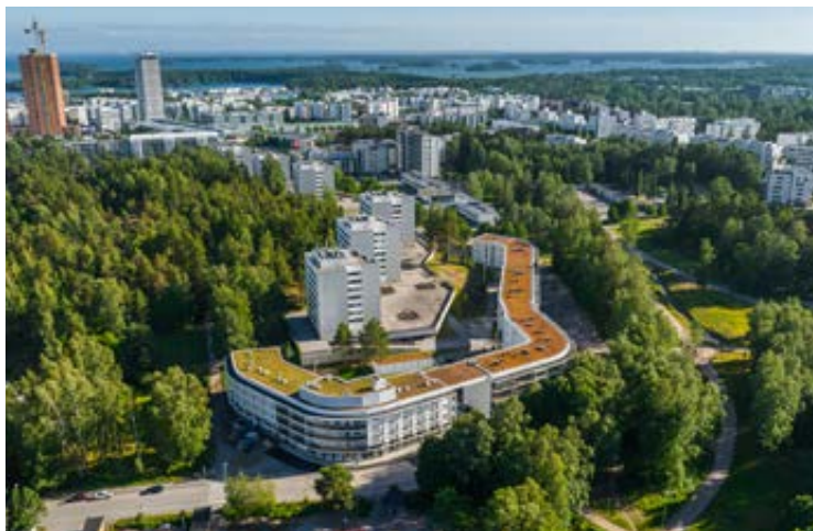
► Maison de repos et de soins – Helsinki (FI)
