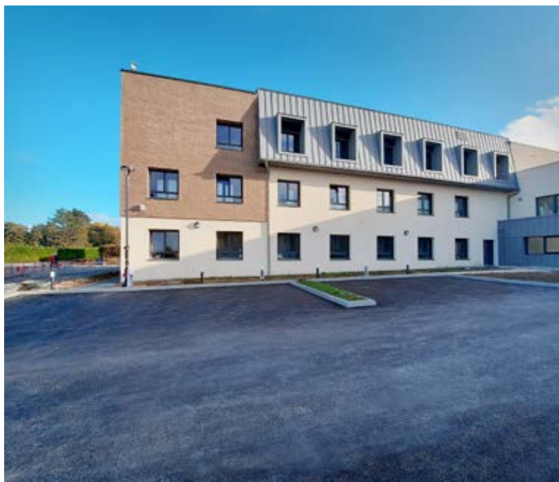
► Maison de repos et de soins – Villers-sur-Mer (FR)
