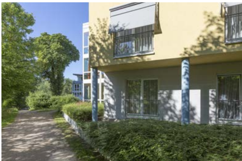
► Maison de repos et de soins – Lünenburg (DE)
